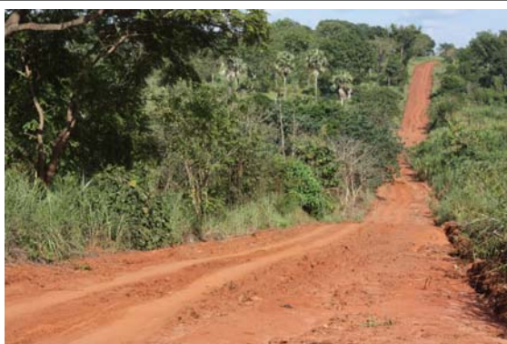
Abb. 15: Unbefestigte Straße in Ghana Fig. 15: Dirt road in Ghana
