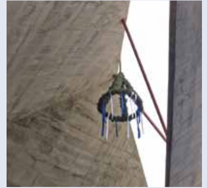
Richtfest im NCT: Im März hängt der Richtkranz im offenen Dach des Nationalen Centrums für Tumorerkrankungen; 2010 Jahr werden hier Patienten behandelt.
