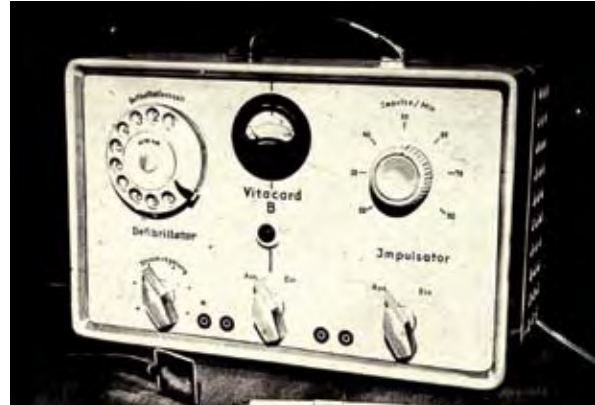
Abb. 3.7a: „Vitacard B“, der erste in Deutschland patentierte Defibrillator mit zusätzlicher Schrittmacherfunktion.
