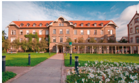
Gebäude der Sprechstunde in der Voßstraße 2
